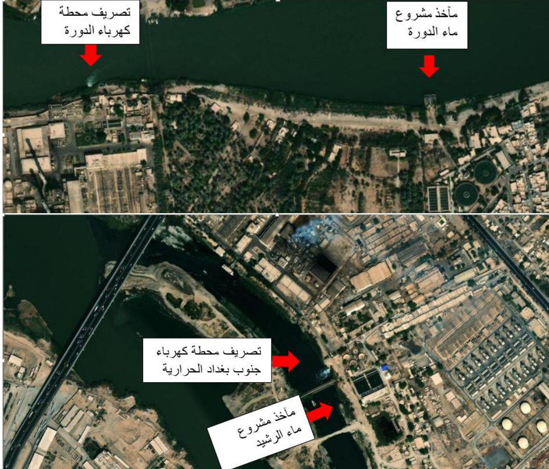
صورة (1-2) تأثير مياه الصرف على مأخذ انابيب تصفية مياه الشرب في مدينة بغداد
